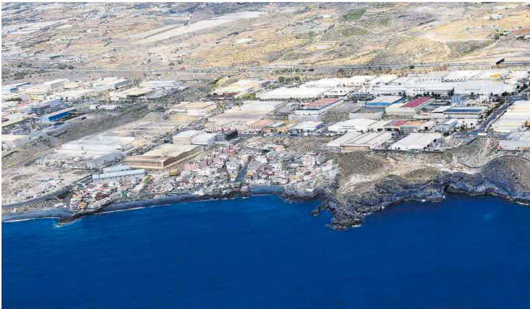
Polígono Industrial Valle de Güímar. | E.D.
