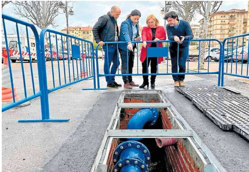
La alcaldesa contempla las obras realizadas en el pozo bajo el recinto ferial, en una imagen de archivo. SUR
