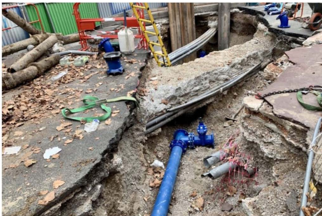
La Métropole de Montpellier investit dans la rénovation des réseaux de distribution d'eau potable.
