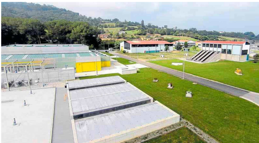
Una vista de la estación depuradora de Villaperi, donde se construirá la nueva planta de regeneración de aguas. e. c.
