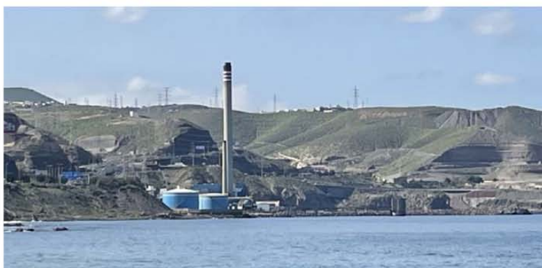
Planta desaladora de Emalsa en Piedra Santa. / AH
